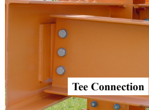
Shear End-Plate
